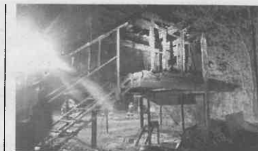
Die Fischerhütte steht bei Stillfried an der March.
